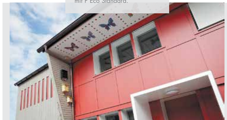
Einfamilienhaus in Trogen/AR mit P Eco Standard.
